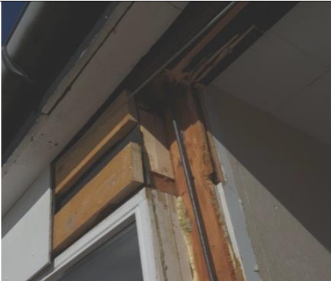
Forud; bl.a. ses bardunen, hvis formål er at fastholde tagremmen
