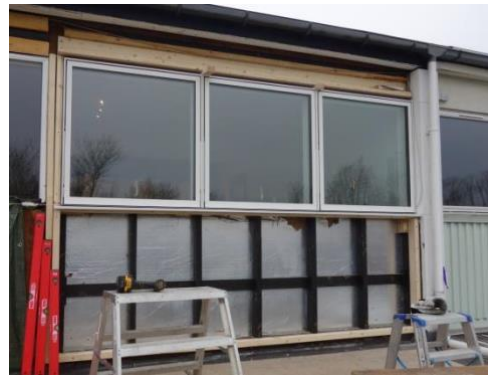
plads til ca. 170 mm isolering
