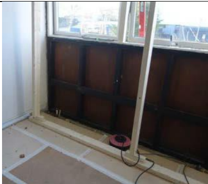
Punkt 1 - Understøttelse af loft/tag (midlertidig)
