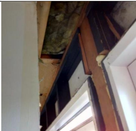
Punkt 1 - Understøttelse af loft/tag (midlertidig)
