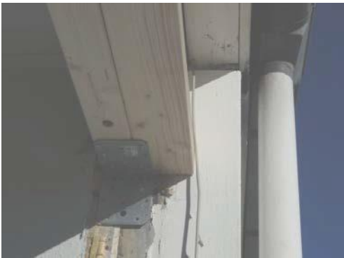
Fæstning af limtræsbjælke i mursiden.
