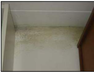
Billede 4: Fugt på inderside af tung facade. (foto)
