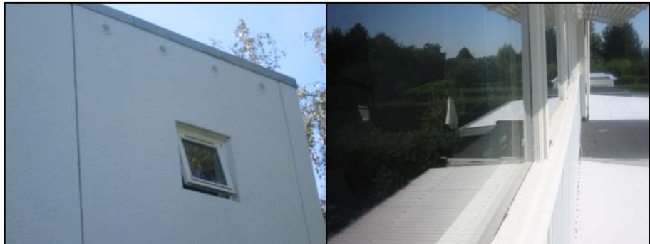
Billede 6: Ventilationshuller i tagrum. (foto)
