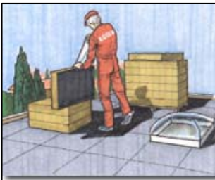
Billede 8: Udlægning af efterisolering på fladt tag. (kilde 9).
