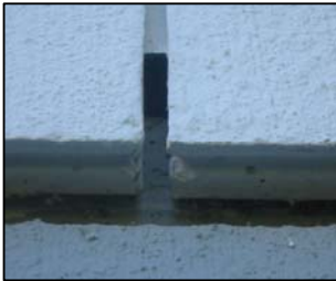
Billede 3: Fuge ved samling mellem elementer. (foto)
