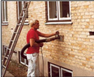
Billede 7: Efterisolering af hulrum. (kilde 20)
