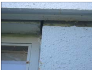
Billede 2: Synligt etagedæk over vinduer på tung ydervæg. (Foto)
